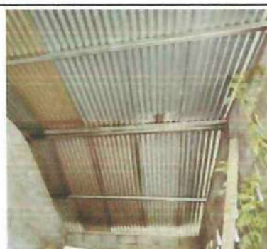
Foto 6: Se observa la necesidad de cambiar parte de la cubierta de lámina del módulo 1.
